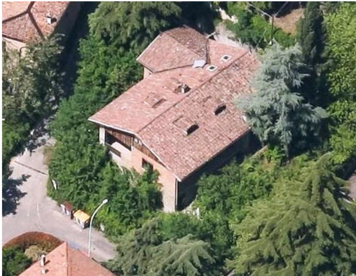
bâtiment faisant l'objet de la démolition
