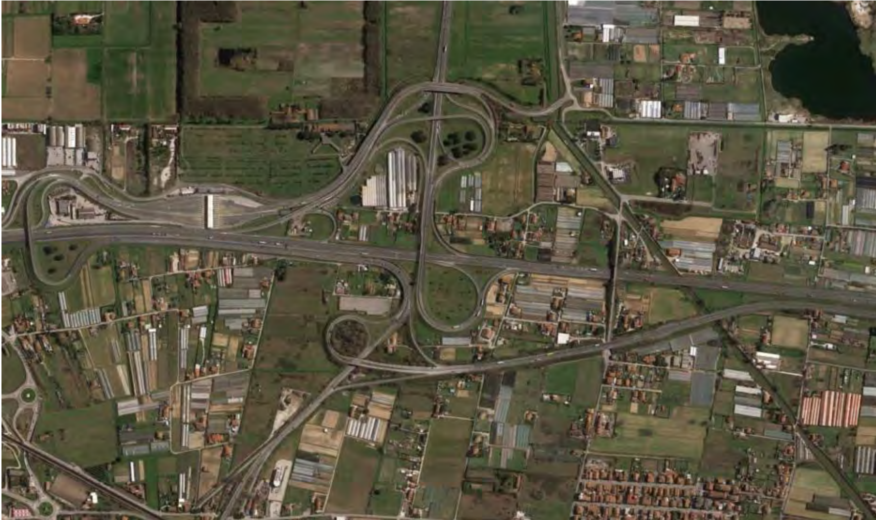
Svincolo Autostradale di Viareggio (Interconnessione A12 e A11) 2006
