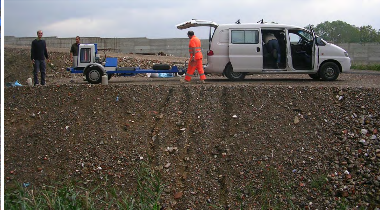
Svincolo Autostradale di Viareggio (Interconnessione A12 e A11) 2006
