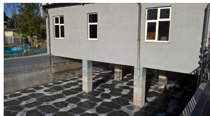
Vasca di ossidazione biologica ed edificio compressori
